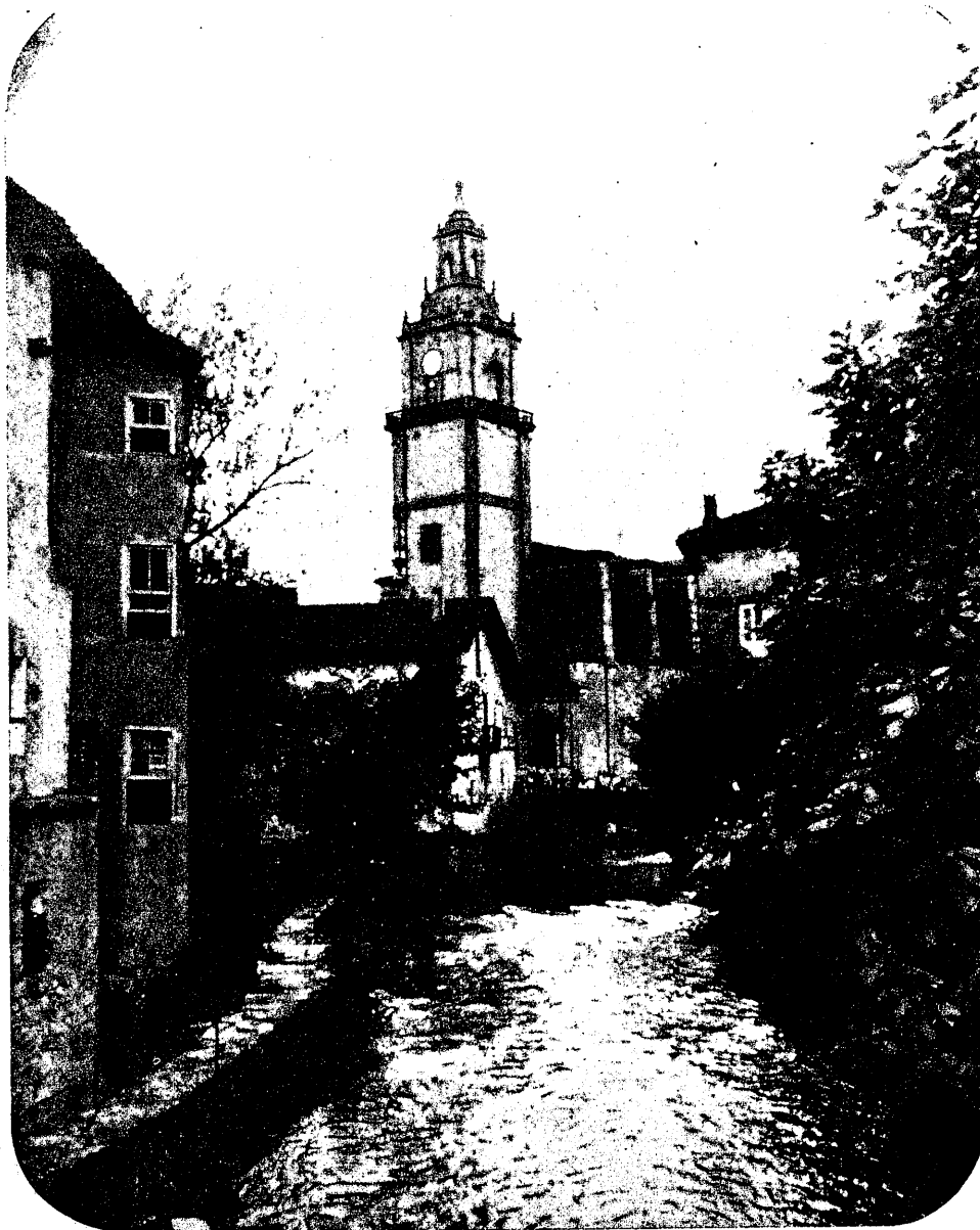
Torre de la Iglesia de Santa Ana de Durango (Bizkaia)
