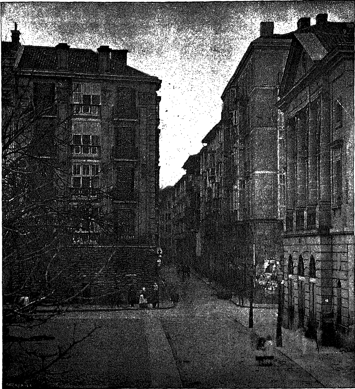
Parapetos formados en el edificio del "Hotel Antonia"
