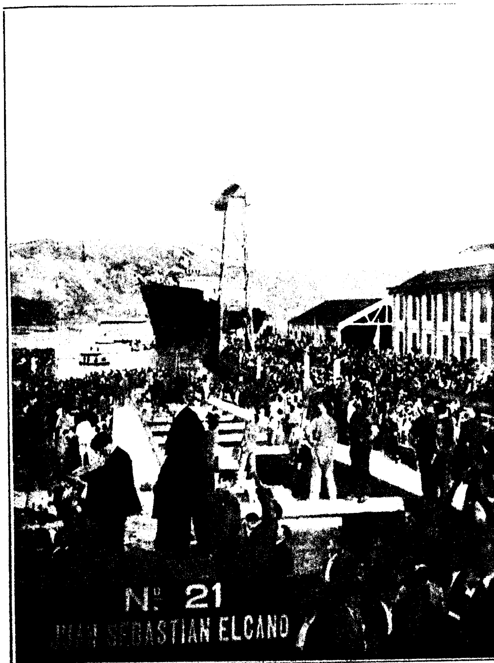
Colocación de la quilla del nuevo transatlántico "Juan Sebastián Elcano", después de la botadura del "Alfonso XIII", que se vé flotando majestuosamente sobre las aguas.
