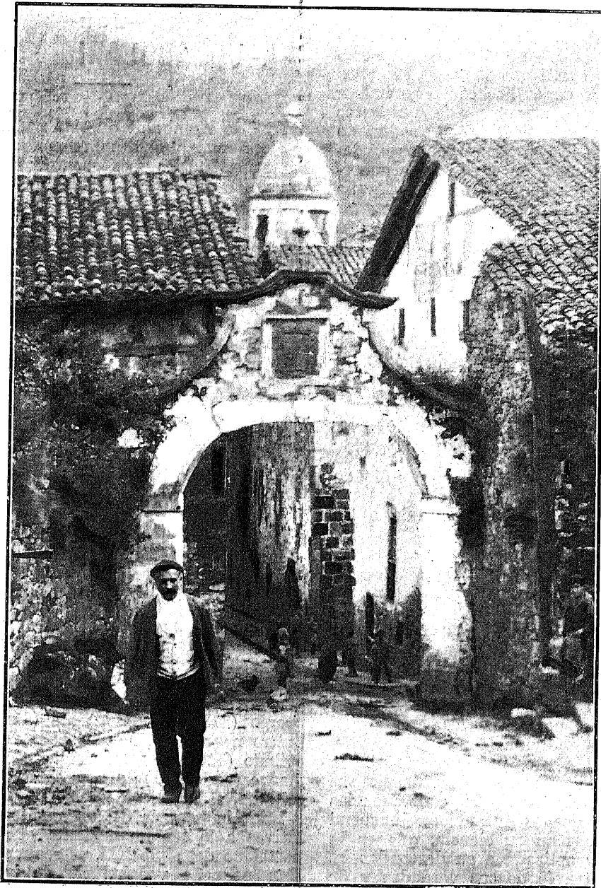
Una de las puertas antiguas de Salinas de Leniz
