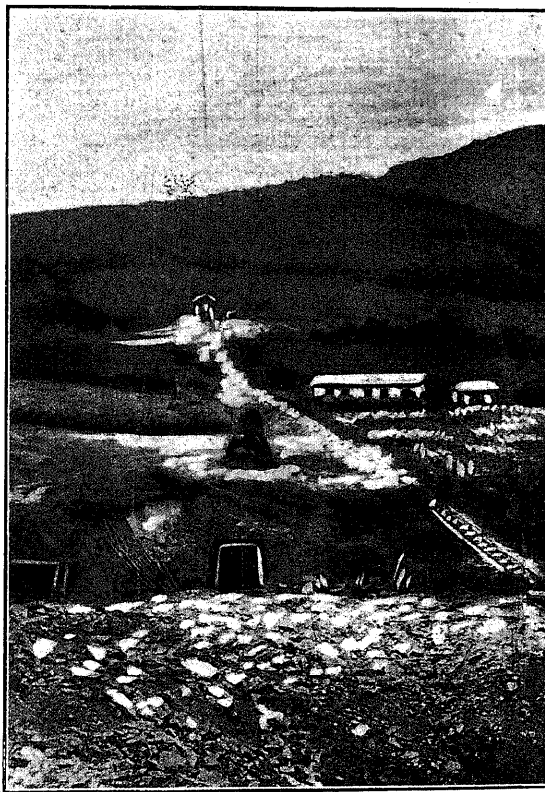
Plano inclinado y bocamina, en Berastegi
