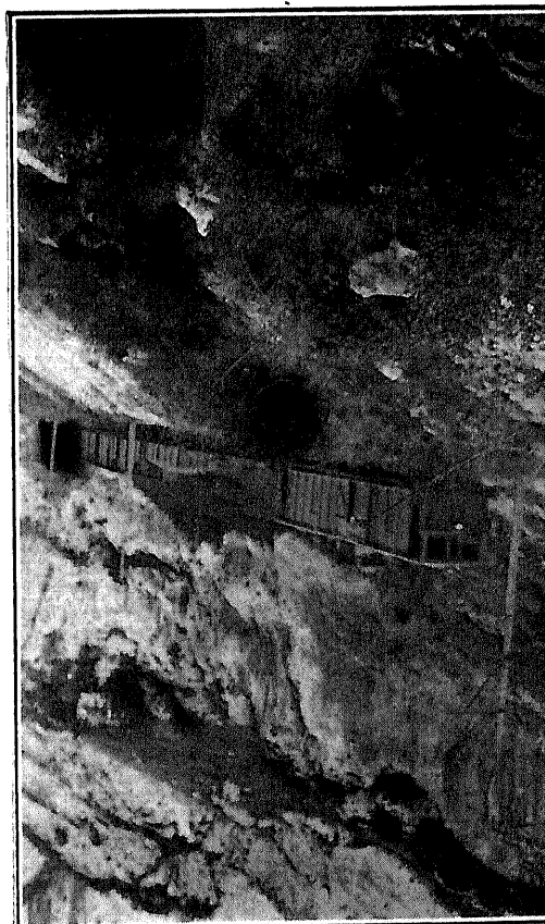
Convoy del ferrocarril "El Irati", saliendo de un túnel de la Foz de Lumbler (Fot. Carlos Primo)
