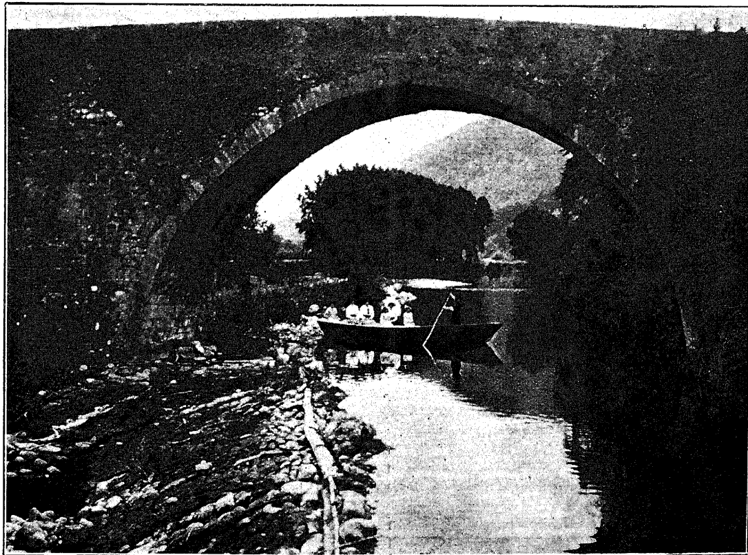
Puente de Sumbilla, sobre el río Bidasona
