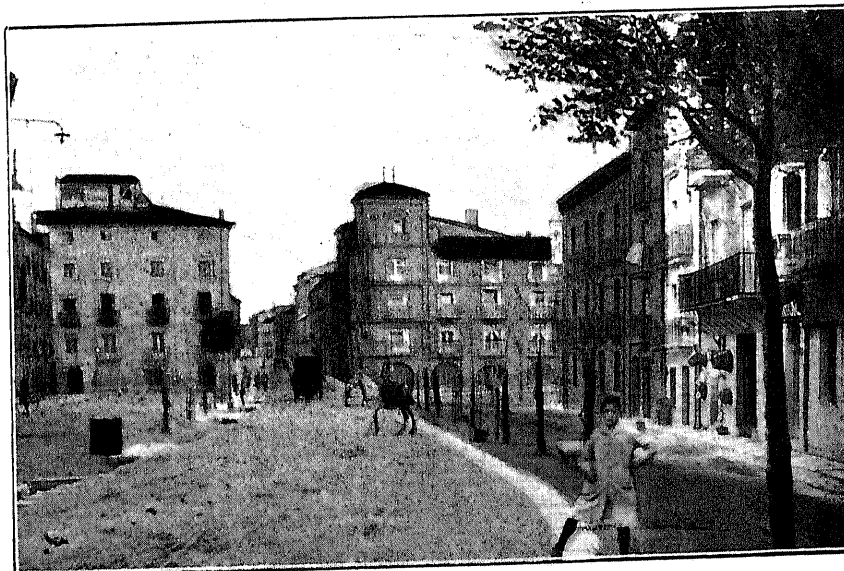
TAFALLA. — Calle del Cadarso y carretera principal
