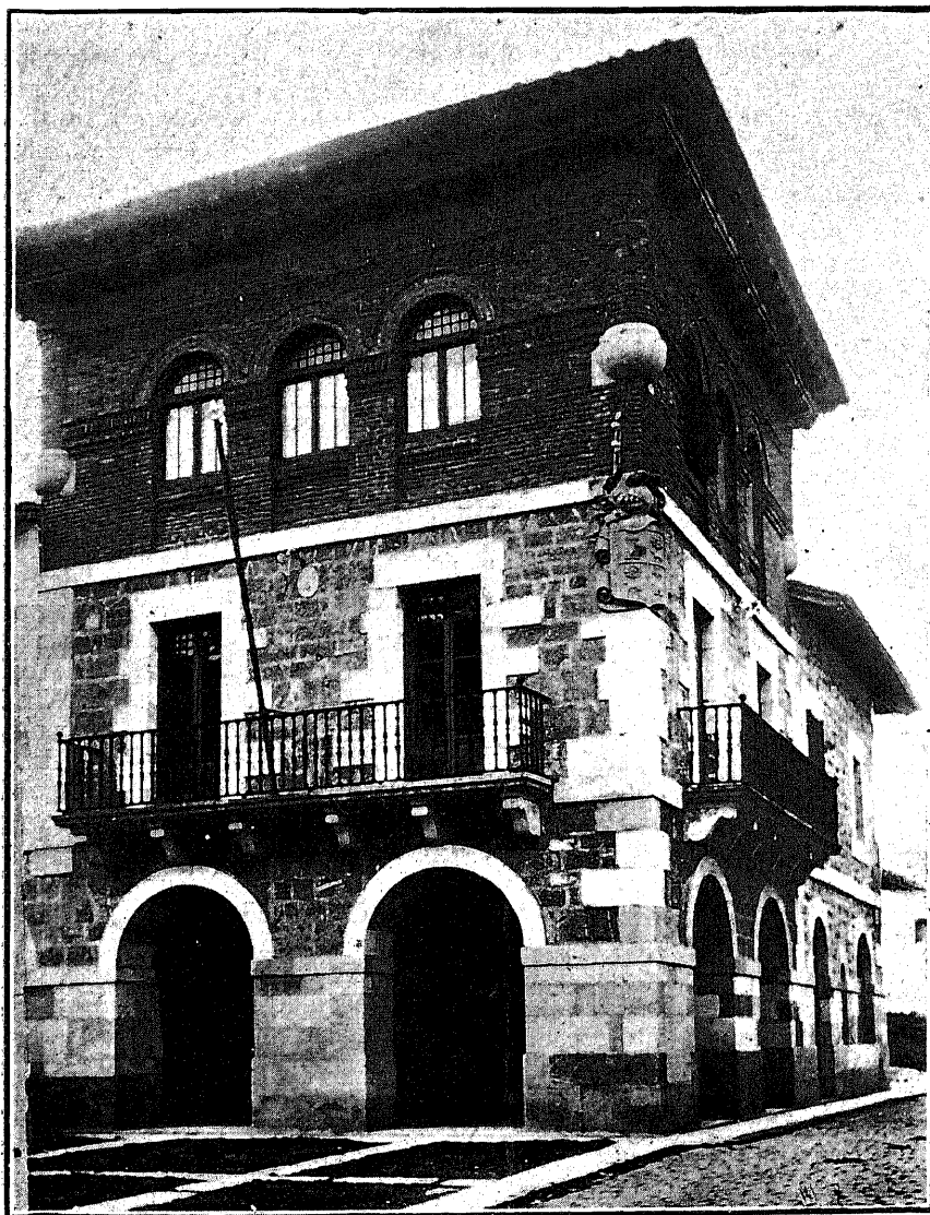
BIDANIA.—(Gipúzkoa) La nueva Casa Consistorial
