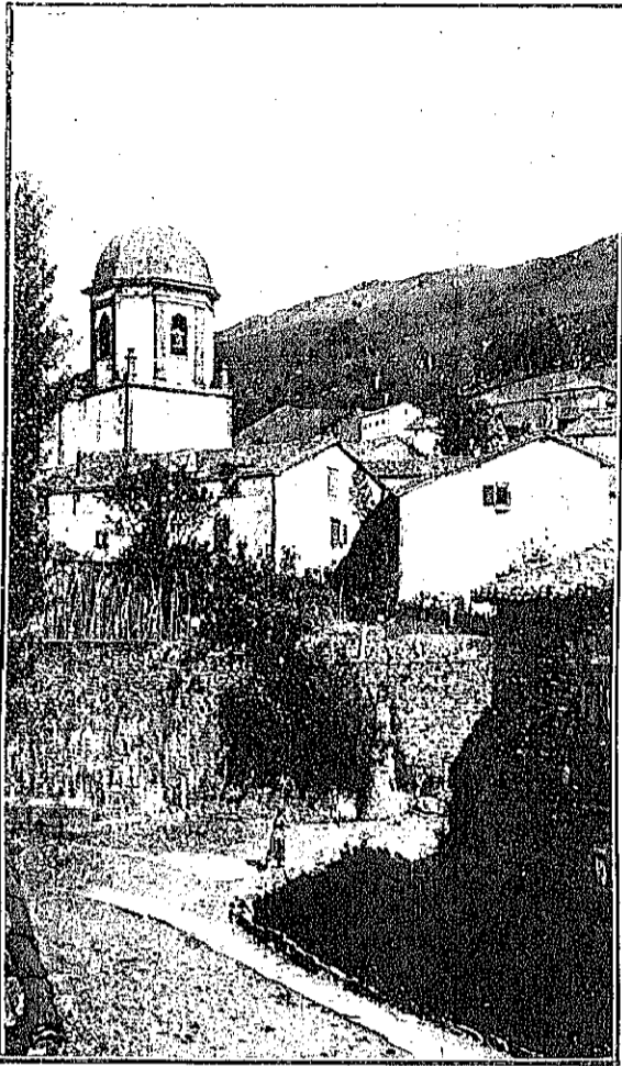
ZUGARRAMURDI (Navarra.) — Calle de Abajo.
