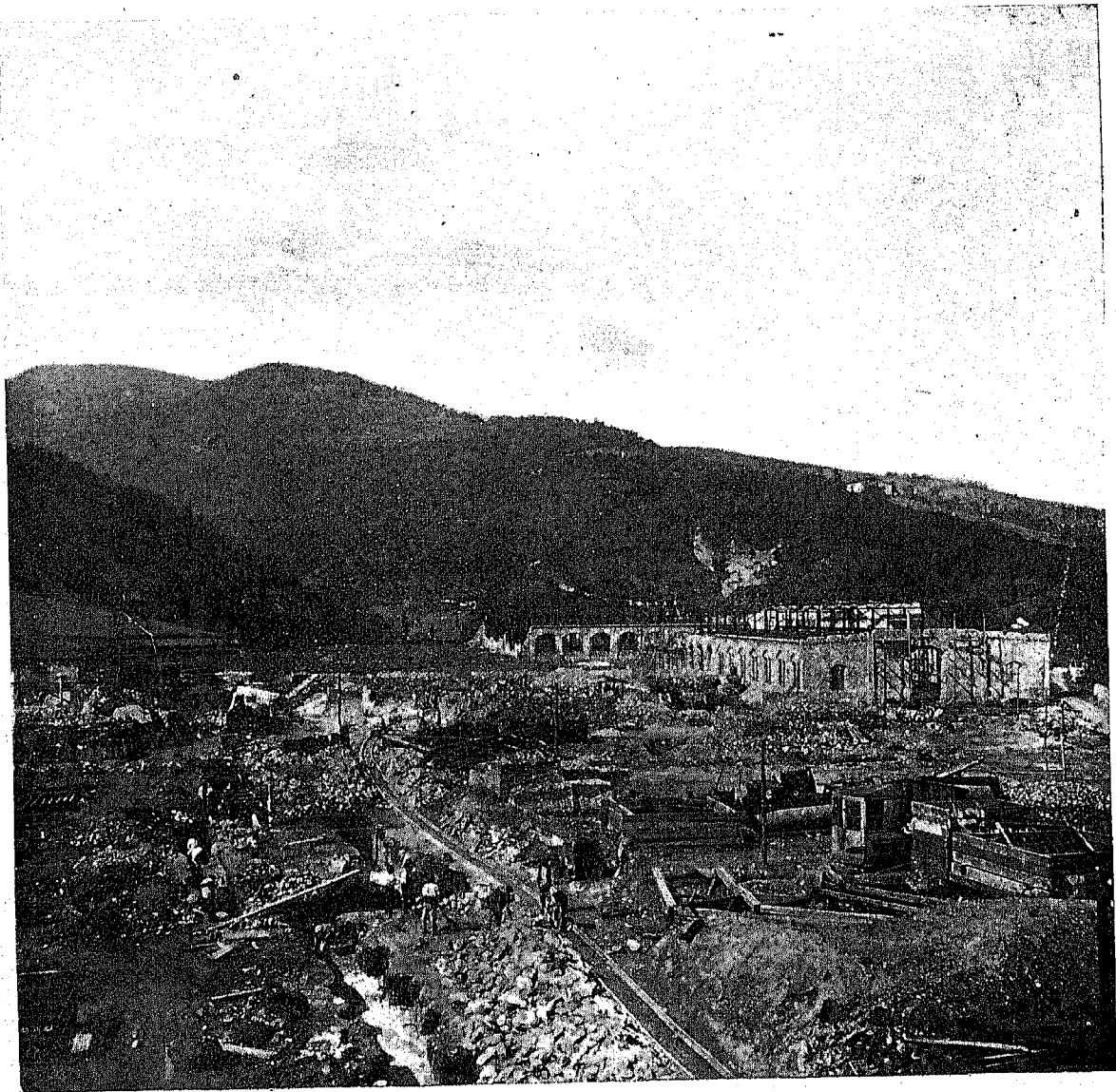
BEASAIN.—OBRAS DE LA FÁBRICA DE CONSTRUCCIONES METÁLICAS
