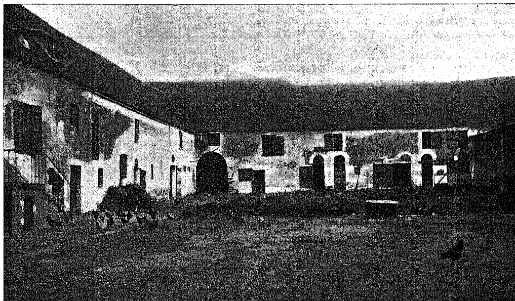
Patío de quinta antigua.—Se vé en el centro un estercolero mal cuidado
