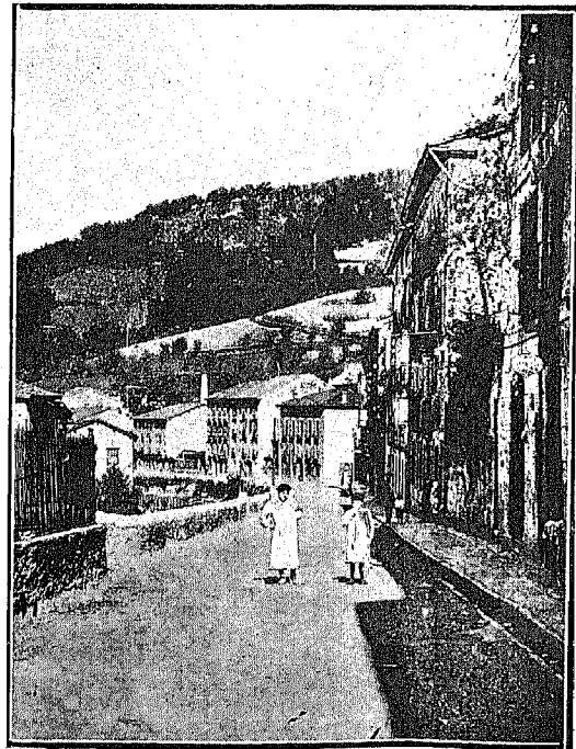
EIBAR (Gipuzkoa)—Calle Bidebarrieta
