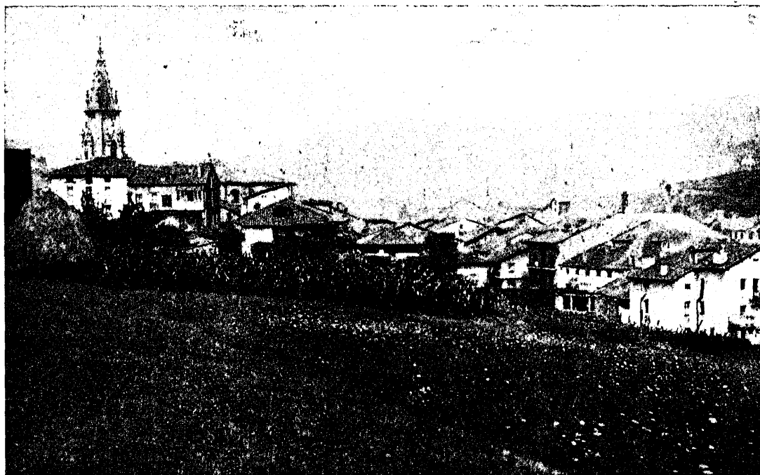
RENERÍA (Gipúzkoa).—Vista desde el Cementerio.
