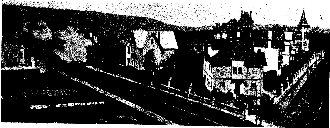
El nuevo barrio Neguri (Bilbao) recientemente inaugurado
