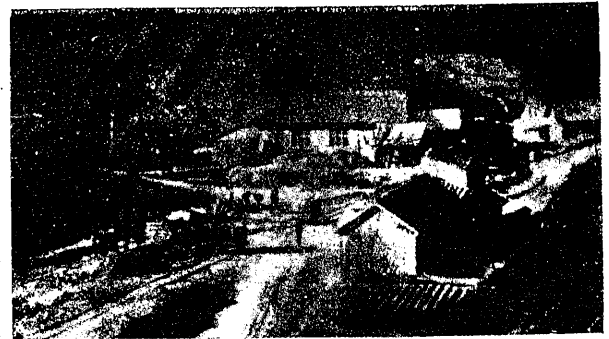
Boca del lado de Huici, del tunel de la divisoria, de 2.600 mts. de longitud y en el que trabajan, por cada lado 150 hombres.
