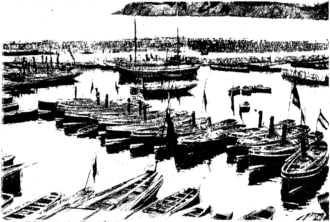
Triste aspecto del puerto de Bermeo, en el que aparecen enlutadas las lanchas con las banderas á media asta, en señal de duelo
