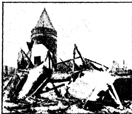
LA IGLESIA DE PLYMOUTH, que ha quedado destruida
