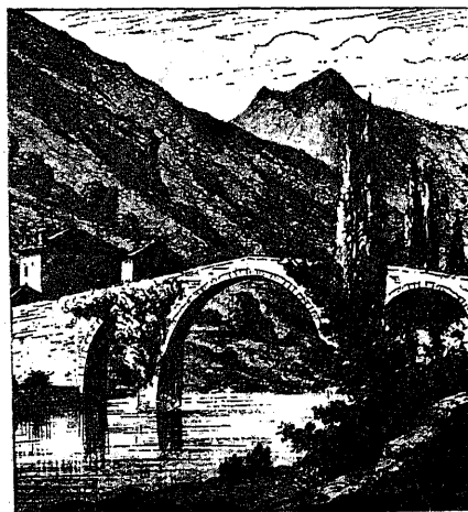
EL PUENTE DE BIDARRAY
