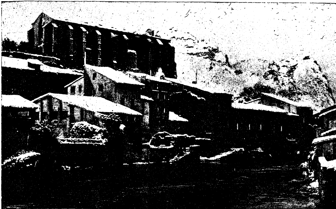
Entrada de la ciudad de Estella, nevada
