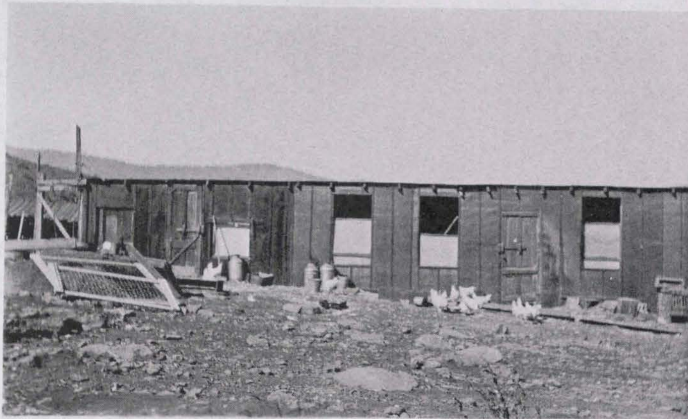
Fig. 18 Old Poultry House L. P. Johnson, Verdi.
